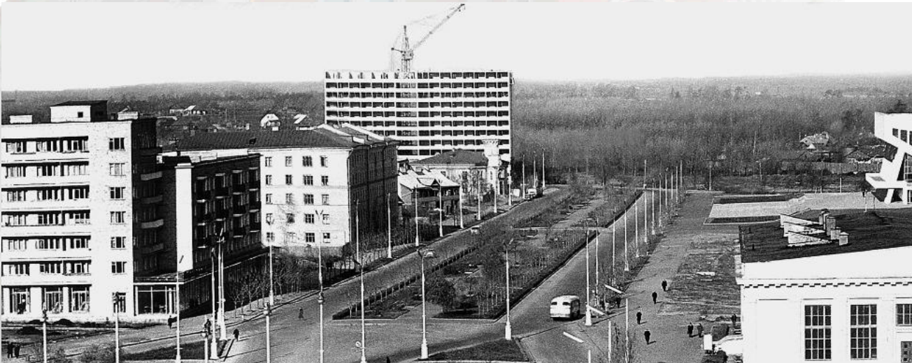
Строящееся здание гостиницы «Юбилейная» на фоне которой видны остатки мечети. Конец 1960-х
